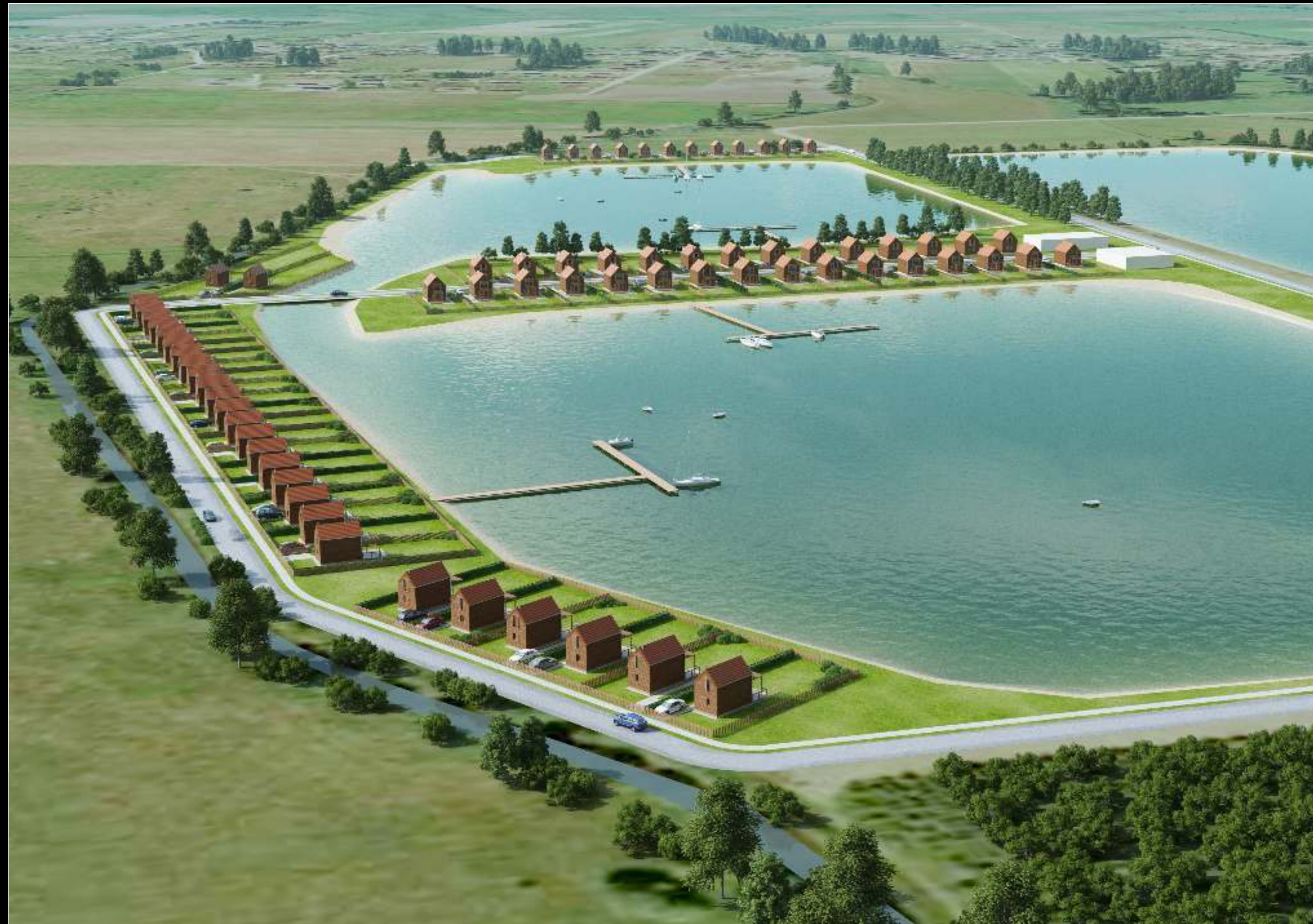
widok od strony południowo - wschodniej
